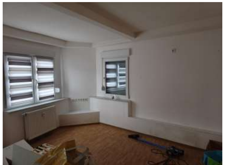
Wohnbereich, Teilansicht EG
